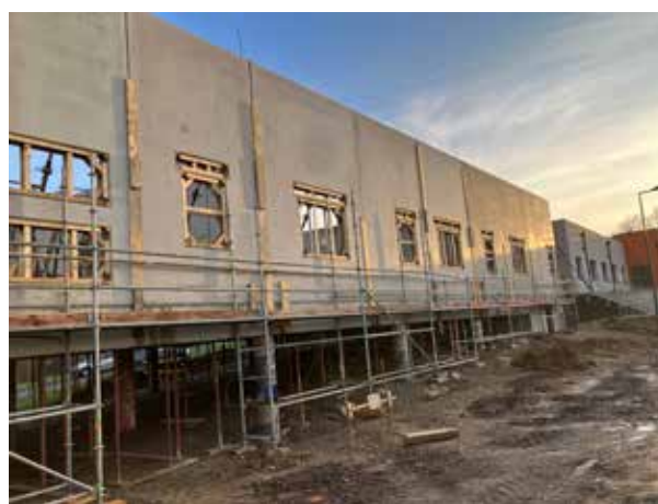
L'extension de la Maison de santé de Sinceny en cours de construction
